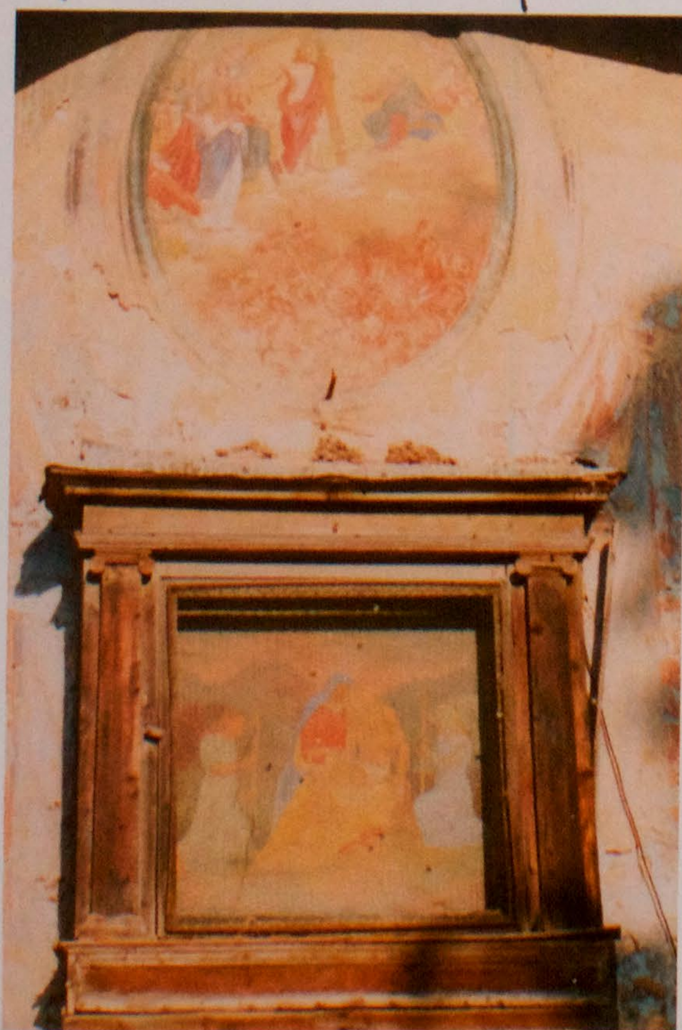
PRIMA DEL RESTAURO
